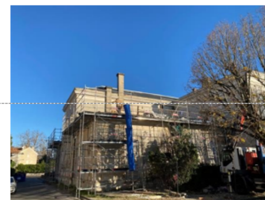
Travaux de toiture de l'ancien tribunal, 2023.
