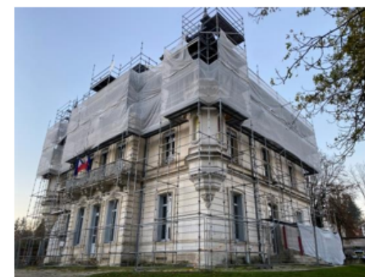
Travaux de toiture de la mairie de Ribérac, septembre 2022
