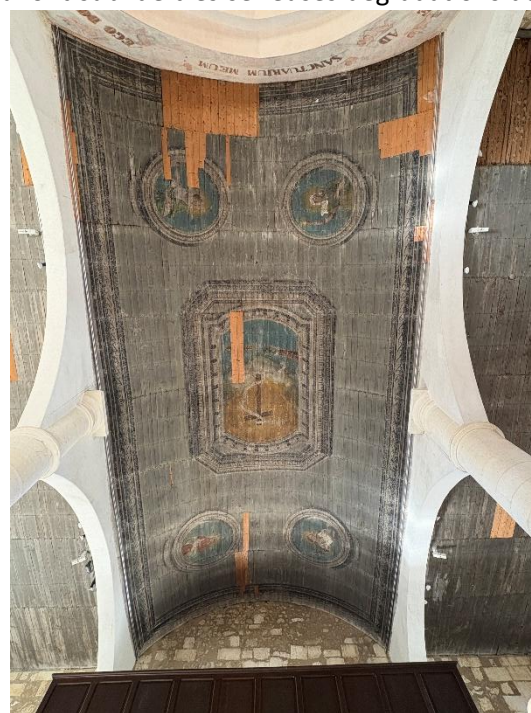
Plafond d'origine de la Collégiale avant travaux
