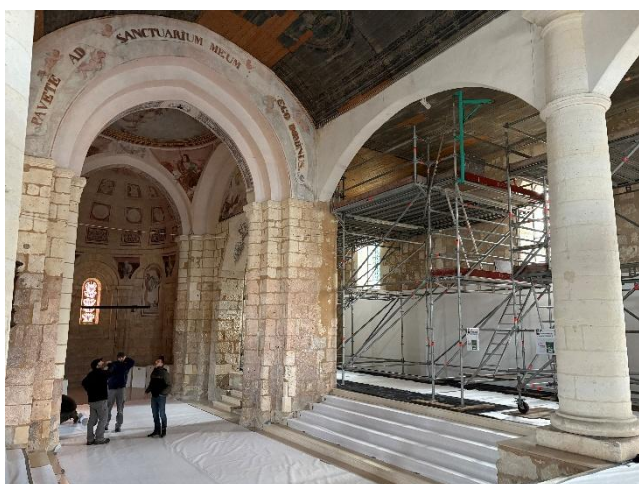
Installation échafaudages – novembre 2025
