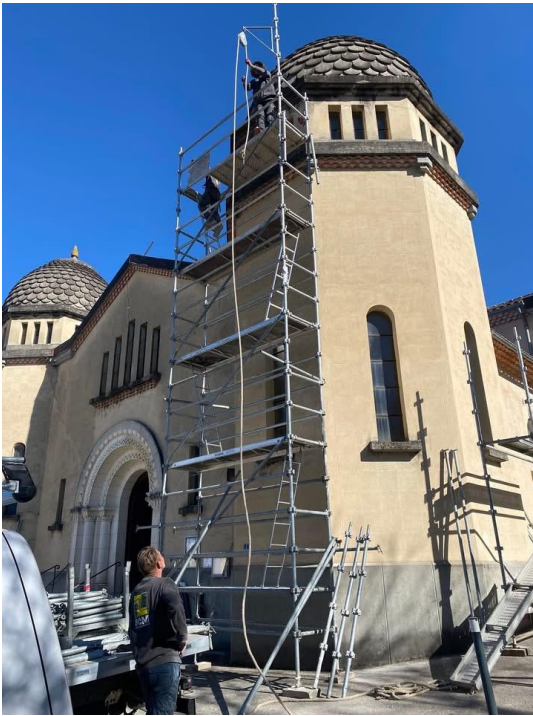
Installation échafaudages – mars 2026
