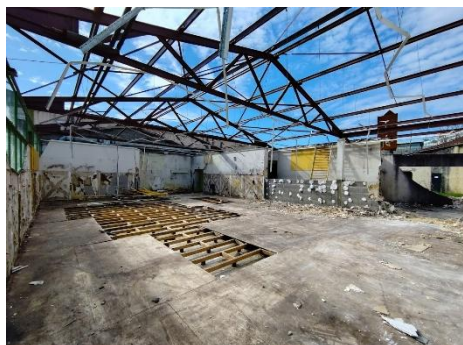
Travaux de démolition de l'ancien gymnase – mars 2025
