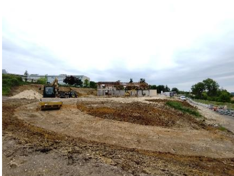
Travaux de terrassement du nouveau bâtiment – mai 2025
